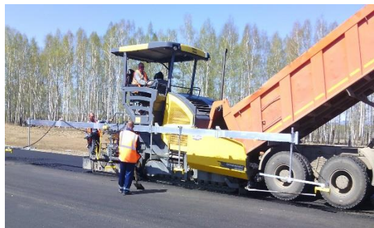
Der Big Sonic-Ski mit vier Sensoren erreicht höchste Ebenheit bei der Sanierung der Verbindungsstraße von Irkutsk nach Taishet
