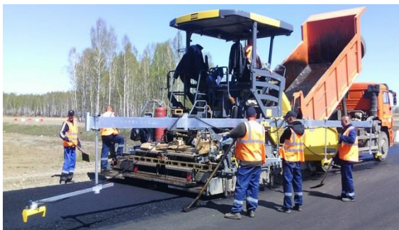
Der Big Sonic-Ski mit vier Sensoren erreicht höchste Ebenheit bei der Sanierung der Verbindungsstraße von Irkutsk nach Taishet
